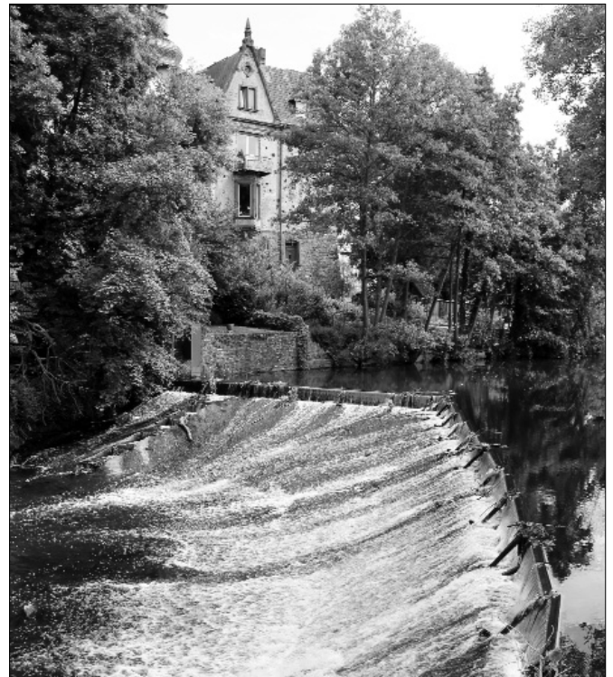
Blick auf die Urft-Wehranlage des früheren Eisenwalz- und Schneidewerks 'Poensgen & Schoeller' in Gemünd. (Foto: Schüler, 3.8.2013)
