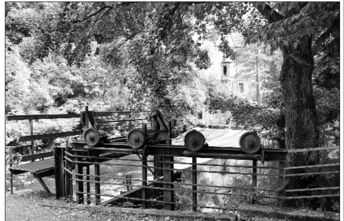
Regulierung der Wasserzufuhr zum ursprünglich parallel zur Urft verlaufenden 'Schneidmühlgraben', der nach 1945 verfüllt wurde. Der Graben lieferte das Wasser für den Antrieb der Wasserräder der Metallfabrik. Der Betrieb befand sich nahe des heutigen Kulturzentrums in Gemünd. Ab 1928 versorgte eine Turbine im Mühlgraben das spätere Mädchenpensionat der Dominikanerinnen 'St. Katharina' mit Elektrizität. (Foto: Schüler, 3.8.2013)
