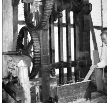
Knochenmühle Finnentrop-Fretter , um 1900 zur Versorgung des benachbarten Hofes Ruhrmann errichtet. Eisernes Stampfwerk vom Typ der 'Kalifornischen Erzepoche' (1860), aus einer Erz- und Schlackeepoche übernommen. Transmission zum Betrieb anderer Geräte (Schleifstein, Kreissäge) vorhanden. Seit der Instandsetzung 1988 wieder mit einem oberschlächtigen Wasserrad ausgestattet.
