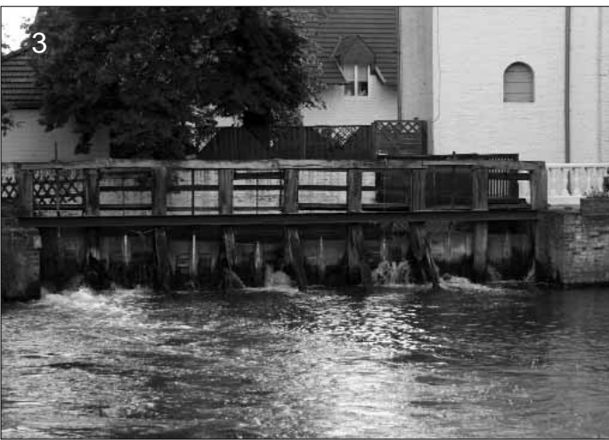
1) Die Aufnahme von 1910 dokumentiert das intakte Ständerwehr und die beiden großen Wasserräder der Zievericher Mühle. 2) Das Foto von 1932 zeigt die Brücke über den Mühlengraben, die Mühle und einen Teil der Hofgebäude. 3) Die Ansicht von 2005 lässt erkennen, dass die Strebenböcke angefault und die Schütze undicht sind. 4) Nach mehrwöchiger Bauzeit wurde die rekonstruierte Wehranlage Anfang Oktober 2012 erstmals geflutet. Die Freiarche erfüllt mit dem Fisch-Bypass an der Schleuse des von der Erft abgehenden Mühlengrabens die EG-WRRL.
