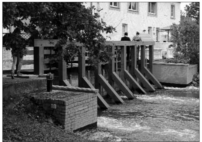
1) Die Aufnahme von 1910 dokumentiert das intakte Ständerwehr und die beiden großen Wasserräder der Zievericher Mühle. 2) Das Foto von 1932 zeigt die Brücke über den Mühlengraben, die Mühle und einen Teil der Hofgebäude. 3) Die Ansicht von 2005 lässt erkennen, dass die Strebenböcke angefault und die Schütze undicht sind. 4) Nach mehrwöchiger Bauzeit wurde die rekonstruierte Wehranlage Anfang Oktober 2012 erstmals geflutet. Die Freiarche erfüllt mit dem Fisch-Bypass an der Schleuse des von der Erft abgehenden Mühlengrabens die EG-WRRL.
