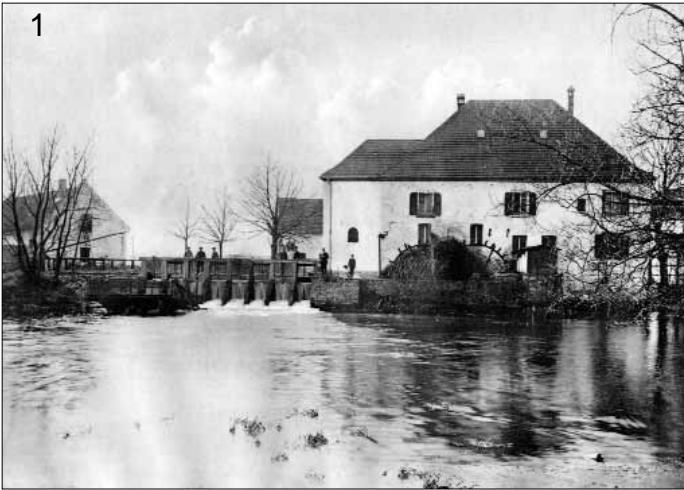
1) Die Aufnahme von 1910 dokumentiert das intakte Ständerwehr und die beiden großen Wasserräder der Zievericher Mühle. 2) Das Foto von 1932 zeigt die Brücke über den Mühlengraben, die Mühle und einen Teil der Hofgebäude. 3) Die Ansicht von 2005 lässt erkennen, dass die Strebenböcke angefault und die Schütze undicht sind. 4) Nach mehrwöchiger Bauzeit wurde die rekonstruierte Wehranlage Anfang Oktober 2012 erstmals geflutet. Die Freiarche erfüllt mit dem Fisch-Bypass an der Schleuse des von der Erft abgehenden Mühlengrabens die EG-WRRL.
