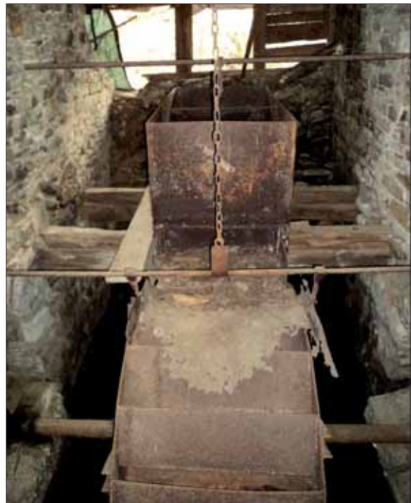
III ef3-MVe14-S-085 Pulvermühle Velken, innen, Radkammer: Oberschlächtiges Zellenrad [e] mit Wasserkasten [f3] von NW.
