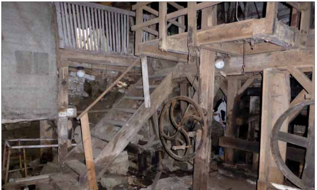
lcd-MVe14-K-025 Pulvermühle Velken, innen: Antriebskeller links oben: Alkoven; Mitte: Treppe zum Mahlboden; rechts Mahlgerüst mit eisernem Kurbelrad für den Sackaufzug [10]; rechts hölzernes Transmissionsrad für die Quetsche.
