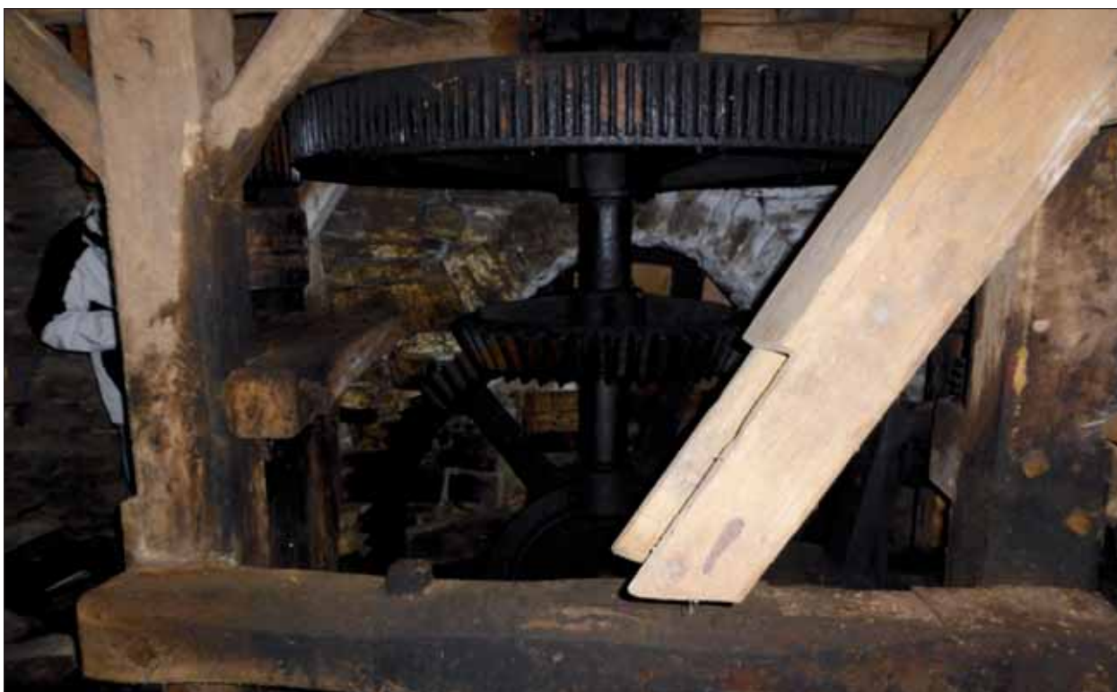
IIId-2-3-4-MVe14-K-040 Pulvermühle Velken, innen: Antriebskeller. Hinten: stehendes Zeug, vorne: Fallrohr von Mahlgang 1.
