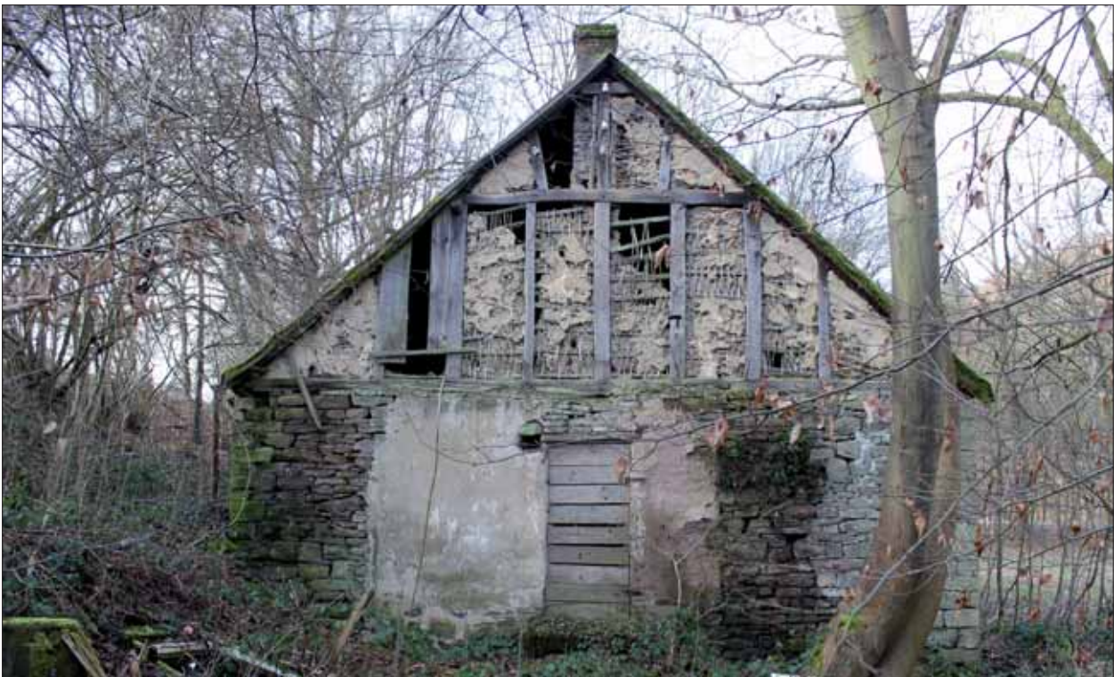
IB-MVe14-S-007 Pulvermühle Velken, außen: Giebelseite von NO.
