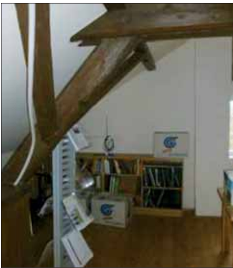
Aussparung in der Schrägstrebe der Dachkonstruktion in ca. 1,85 m Höhe, die auf den Standort des Sichters hindeutet.
