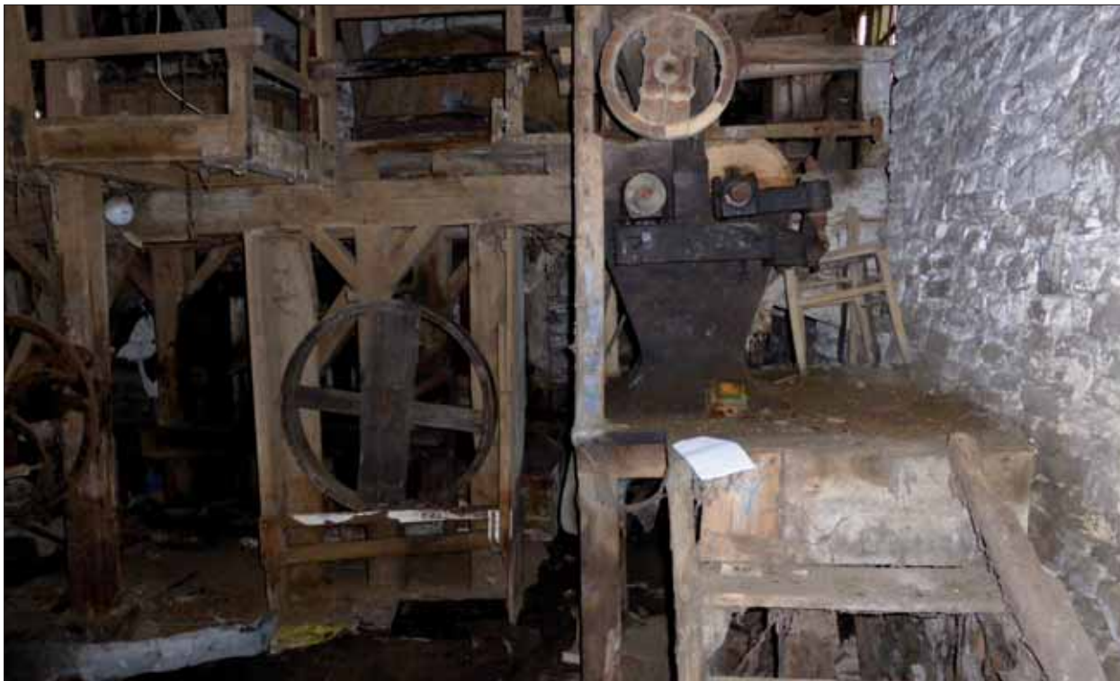
Ida-MVe14-K-027 Pulvermühle Velken, innen: Antriebskeller vorne links: eisernes Schwungrad für den Sackaufzug [10]; vorne rechts: hölzernes Transmissionsrad für den Quetschgang [11]; rechts auf Podest: Quetschstuhl [15].
