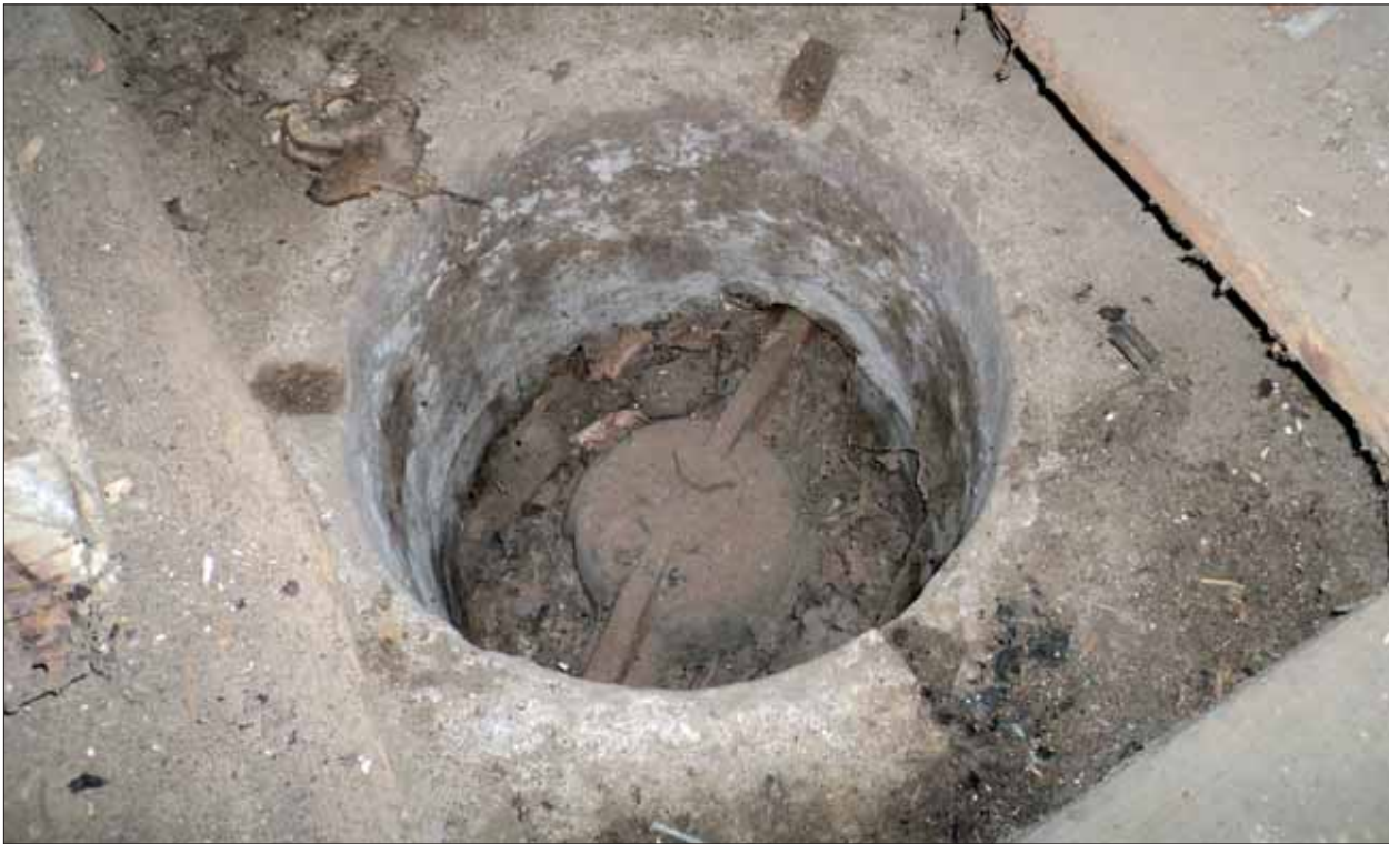
III d1-13-MVe14-S-074 Pulvermühle Velken, innen, Mahlboden: Haue des Läufersteins von Mahlgang 2 [13].
