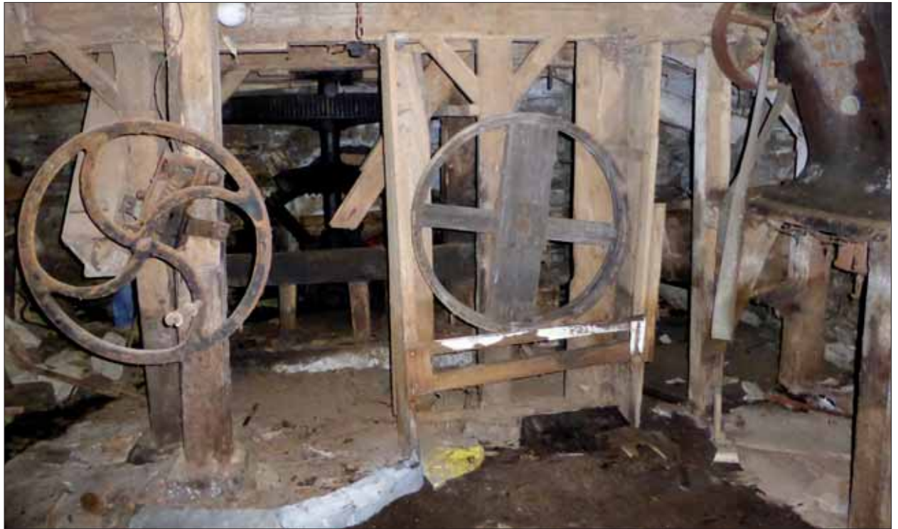
Id-MVe14-K-026 Pulvermühle Velken, innen: Antriebskeller Mahlgerüst; Mitte hinten: Kronrad [2] auf Mühlradwelle, Königswelle mit Ritzel [3] und Stirnrad [4]; vorne links: eisernes Schwungrad für den Sackaufzug [10]; vorne rechts: hölzernes Transmissionsrad für den Quetschgang [11]; rechts auf Podest: unterer Teil des Quetschstuhls [15].
