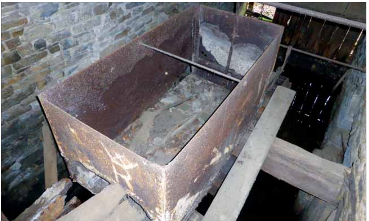
III f3-MVe14-K-096 Pulvermühle Velken, innen, Radkammer: Wasserkasten [f3] des oterschlächtigen Zellenrads [e] von 0.
