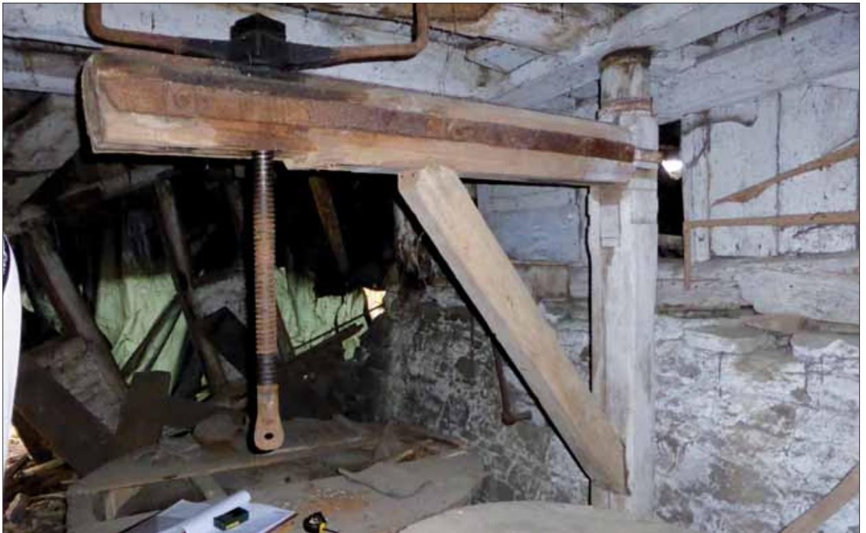
III cd 1-12-13-14-MVe14-K-069 Pulvermühle Velken, innen, Mahlboden, Blick Richtung S; Steinkran über dem Mahlgang.
