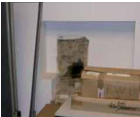
Hinten: Aussparung in der Wand für die ehemals hölzerne Wasserradwelle der Mahlmühle.
