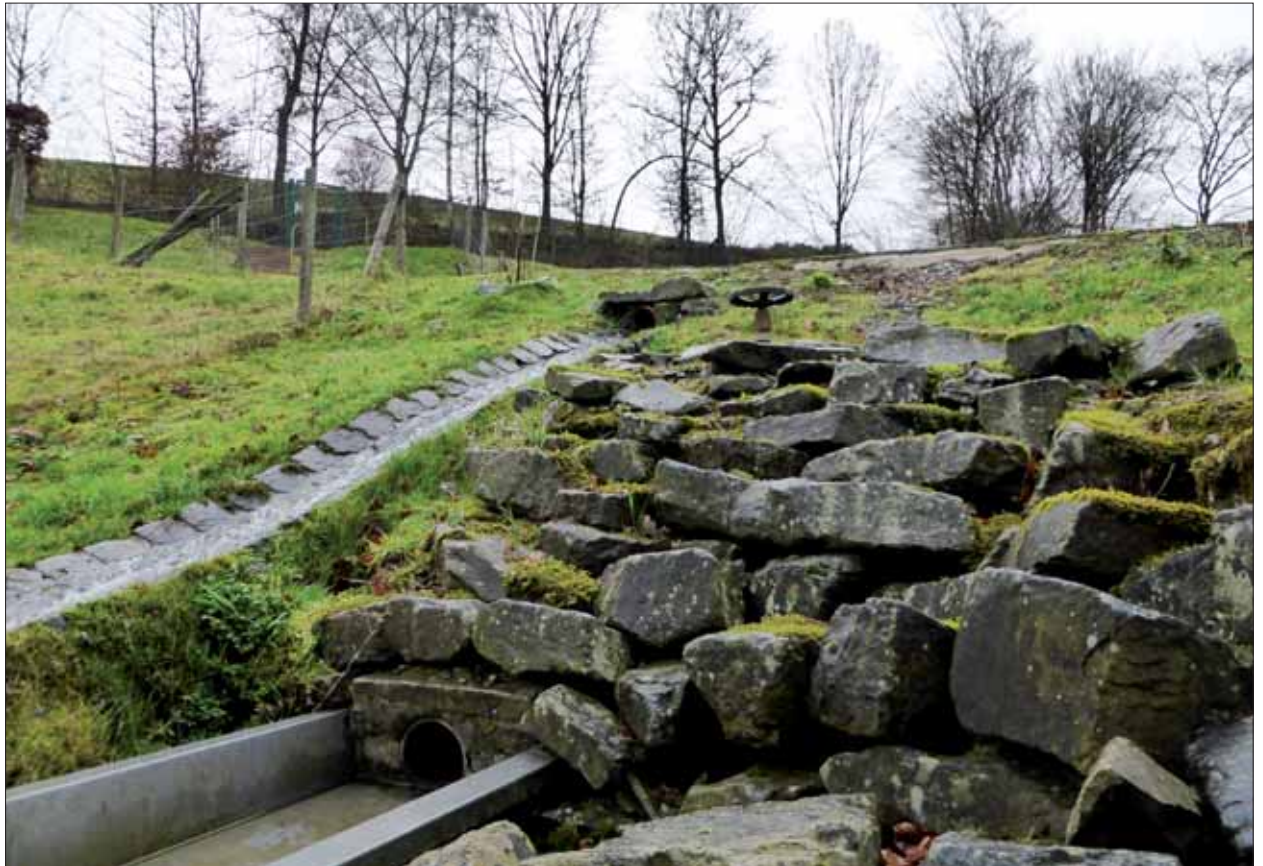
Ilfb-BirM14-K-022 Birkenmühle, außen: Der Staudamm (f1): links die steingefasste Rinne des Überlaufs (h), vorne endet das Entnahmerohr in das offene Mühlengerinne (f3); oberhalb der Steinschüttung das Stellrad (f2).
