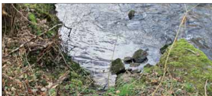
Ilf1-MVe14-S-022 Pulvermühle Velken, außen: ehemalige Einmündung des Untergrabens in die Waldbröl.
