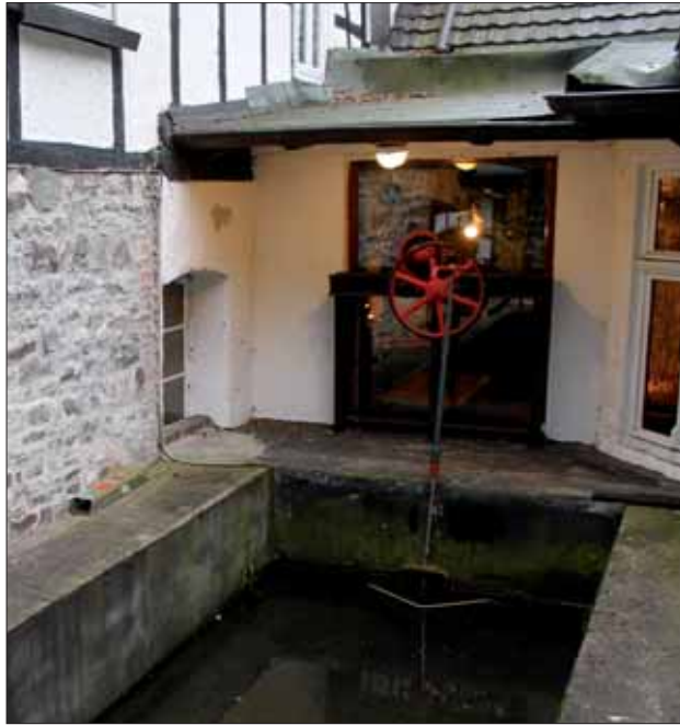
Blick auf das in Beton gefasste Gerinne des ehemaligen Obergrabens der Mühlenanlage mit Zahnstangen-Schütz zur Regulierung der Schüttung auf das Mühlrad.
