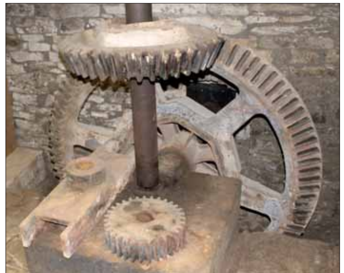
Ilfb-2-3-BirM14-S-036 Birkenmühle. Antriebskeller: Winkelgetriebe mit Vorgelege (stehendes Zeug); hinten Tellerrad (2) auf der Wasserwelle (1), mittig: Ritzel (3) auf der Königswelle.
