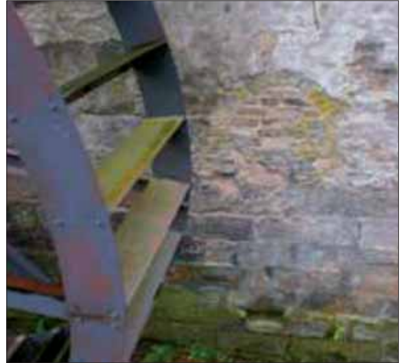
Neben dem heute noch erhaltenen Wasserrad der Mahlmühle ist deutlich das zugemauerte Loch für die Wasserradwelle der ehemaligen Ölmühle erkennbar. Fotos: Rüdiger Hagen (4) (2014).
