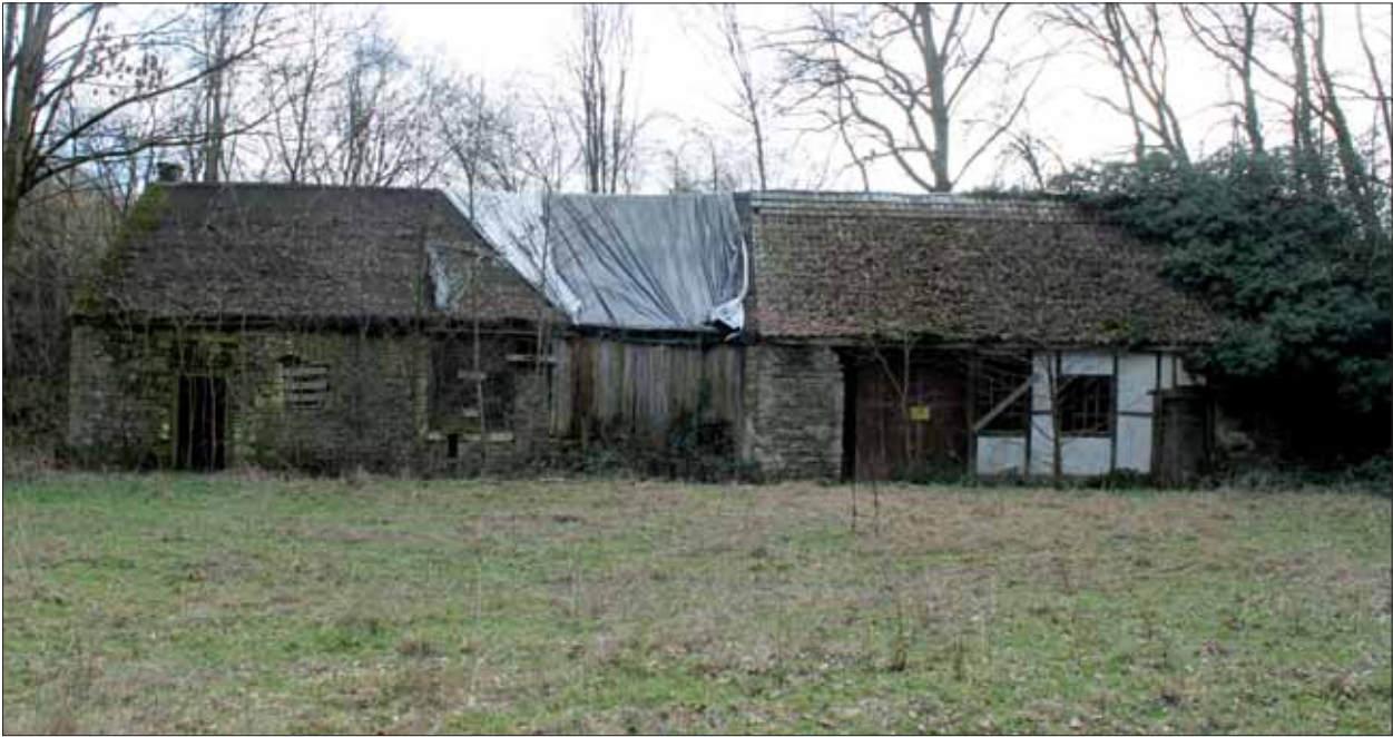
IA-MVe14-S-002 Pulvermühle Velken, außen: Ansicht von NW.
