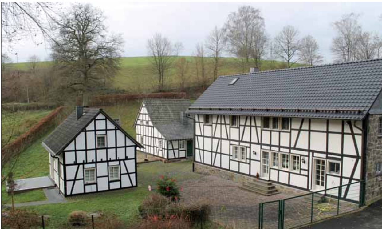
I-BirM14-S-001 Birkenmühle, außen: Gebäudekomplex der Birkenmühle. In der Mitte hinten das Mühlengebäude.
