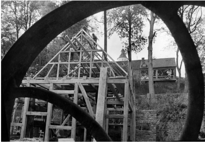
Aufbau der nach Schloss Homburg translozierten Mühle aus Gaderoth, 11.10.1972, © Helmut Steickmann, Heimatbildarchiv des Oberbergischen Kreises.
