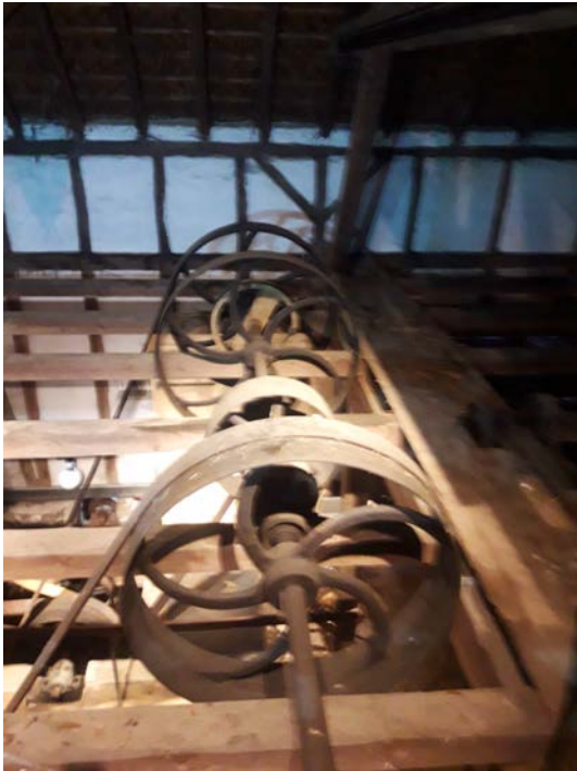
Haupttransmission im Dach, © RMDZ 2024.
