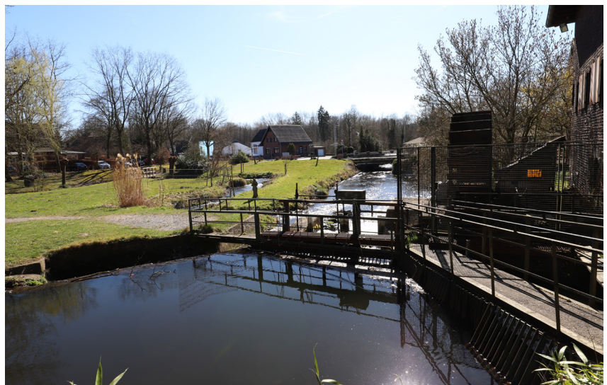
Oberwasser, Bedienbrücke, Grobrechen der Freiarche und des Radgerinnes, Wasserrad
