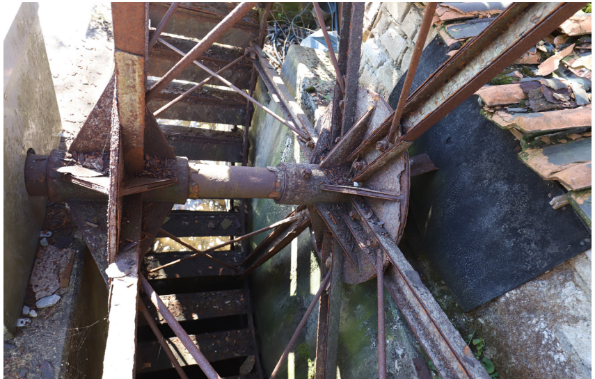
Wasserrad, Detailansicht: Welle, Rosetten
