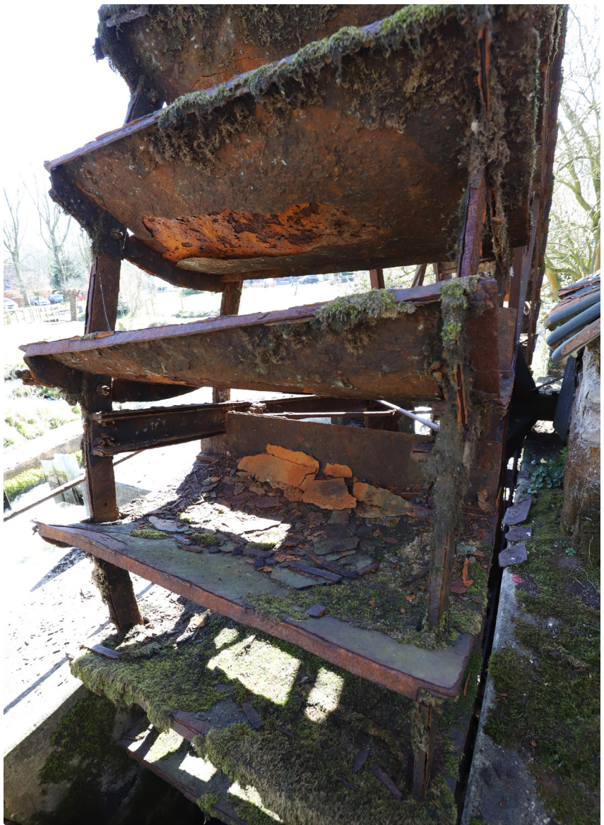
Wasserrad, Detailansicht: gekröpfte Schaufeln mit Aufkantung
