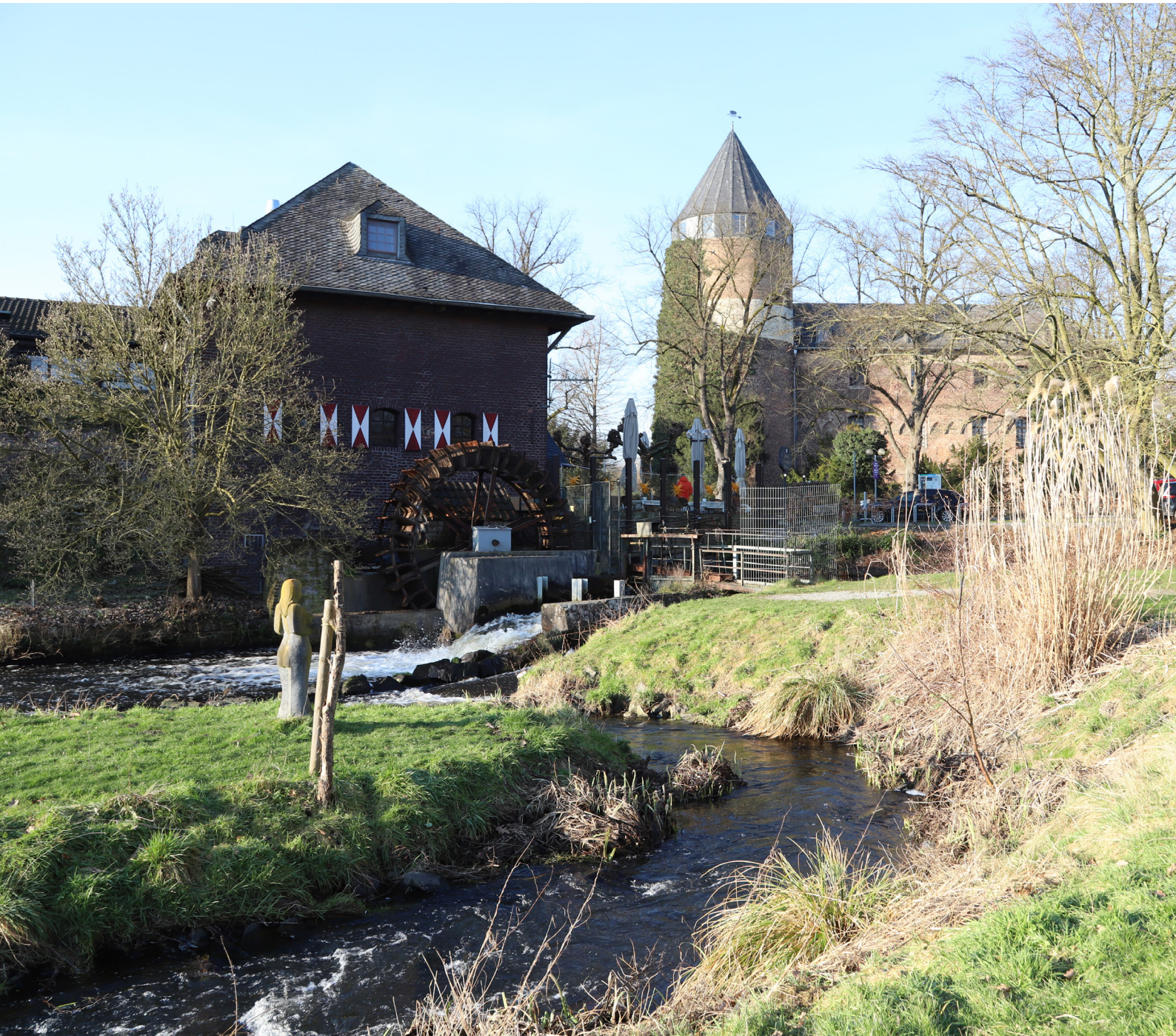
Brügger Mühle, Gesamtansicht mit Fischeufstiegsgerinne
