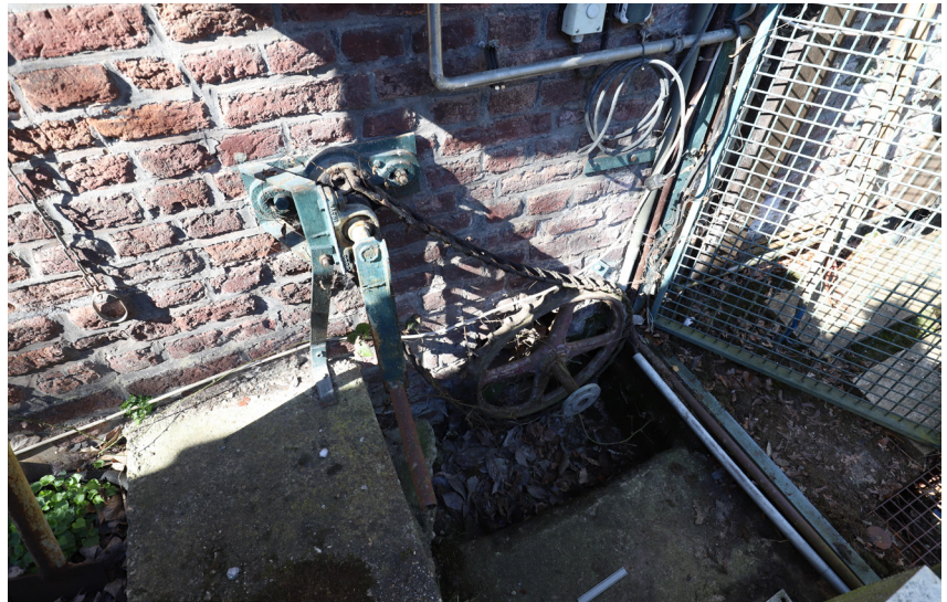
Handkurbel zum Betrieb des Spannschützes
