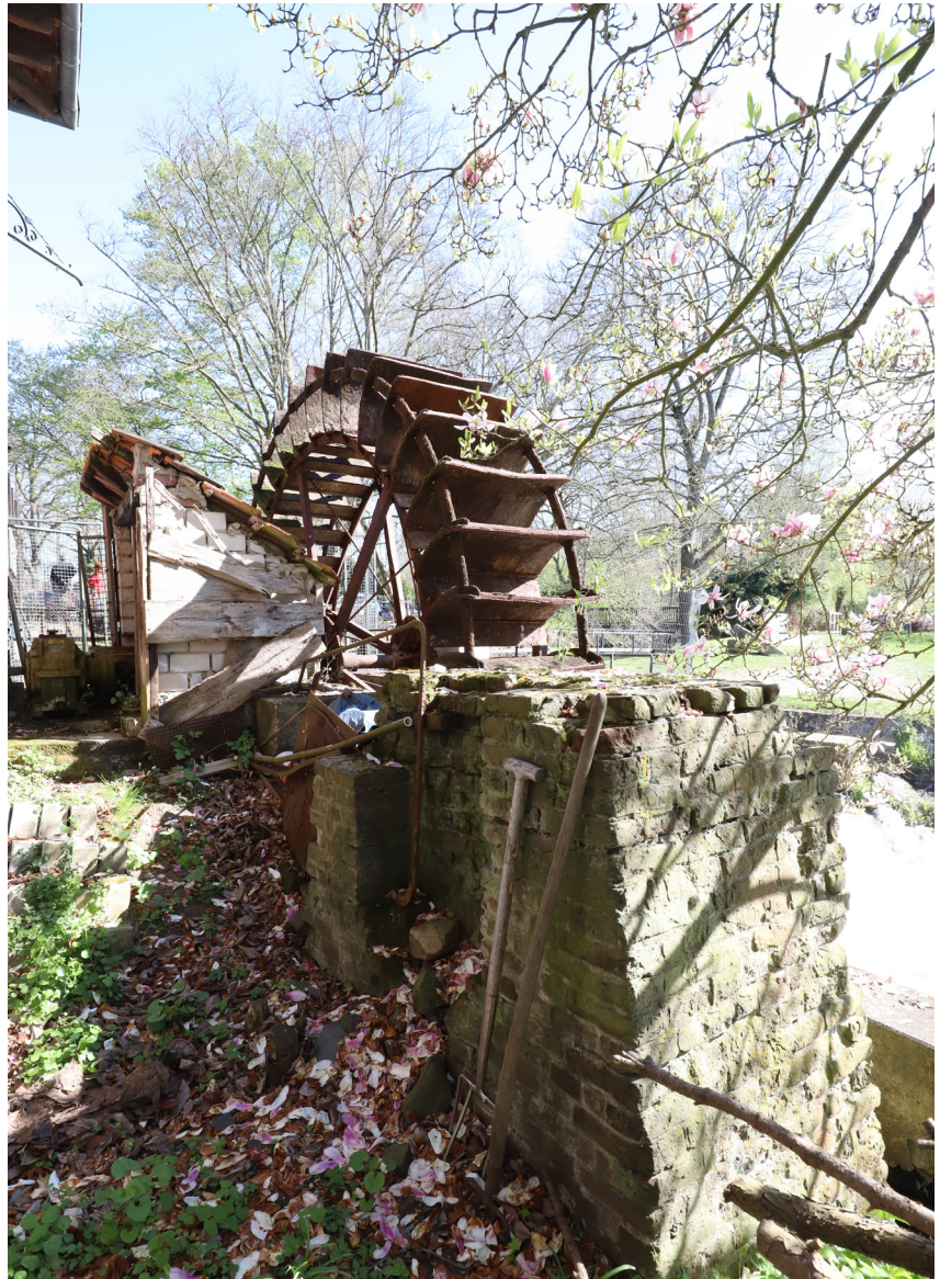
Wasserrad, Generatorschutzdach, verfülltes Gerinne des ehemaligen zweiten Wasserrades
