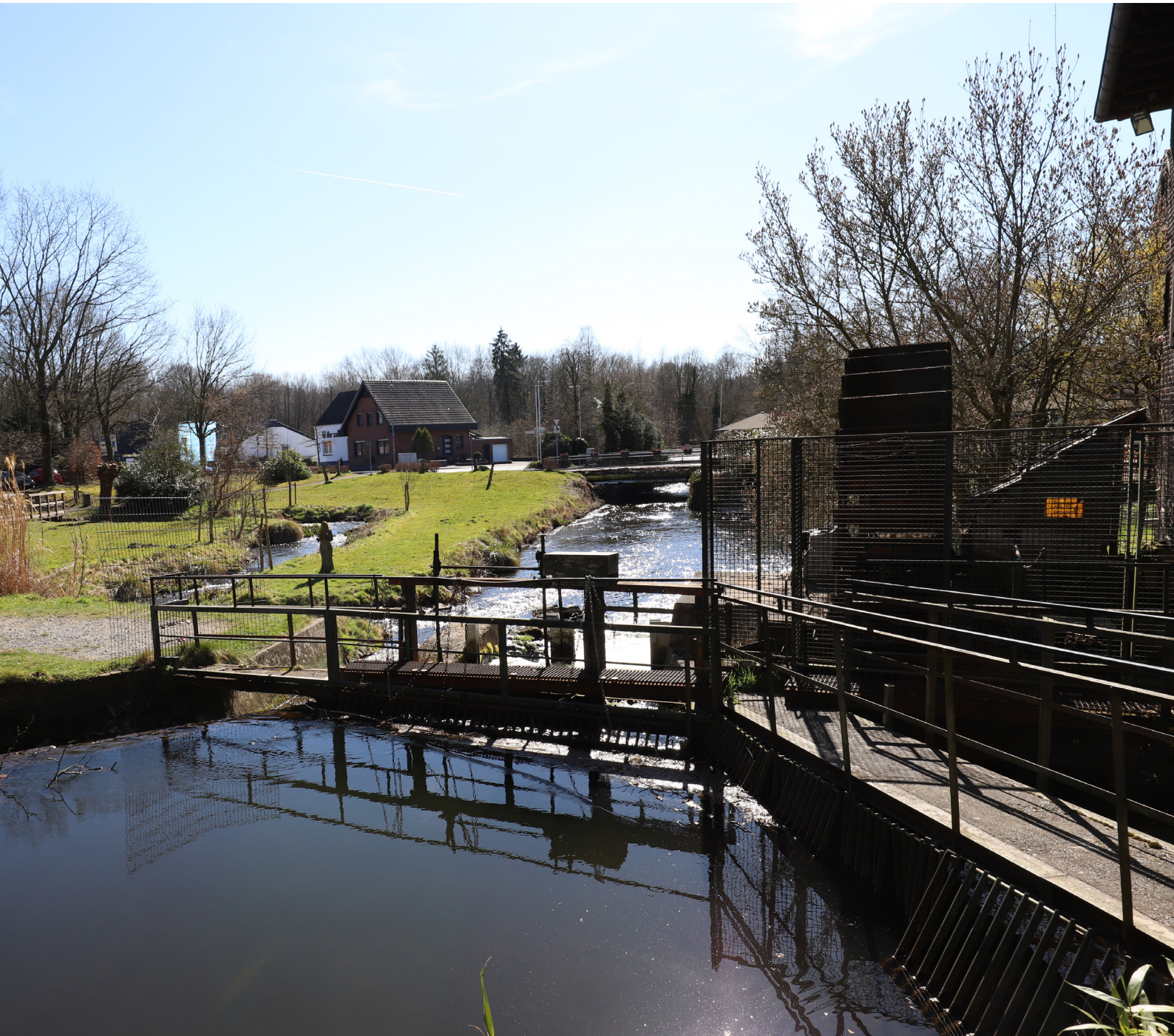
Oberwasser, Bedienbrücke, Grobrechen der Freiarche und des Radgerinnes, Wasserrad
