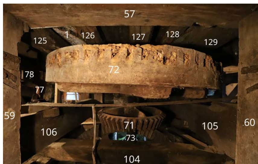
2.48 | Unteres Kellergeschoss, Mahlstuhl: stehendes Vorgelege.
