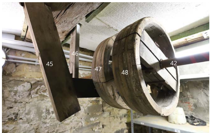
2.10 | Oberes Kellergeschoss: obere Riementransmission, links
