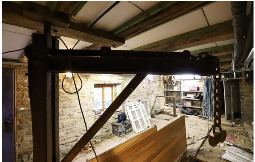
2.21 | Oberes Kellergeschoss: Steinkran.
