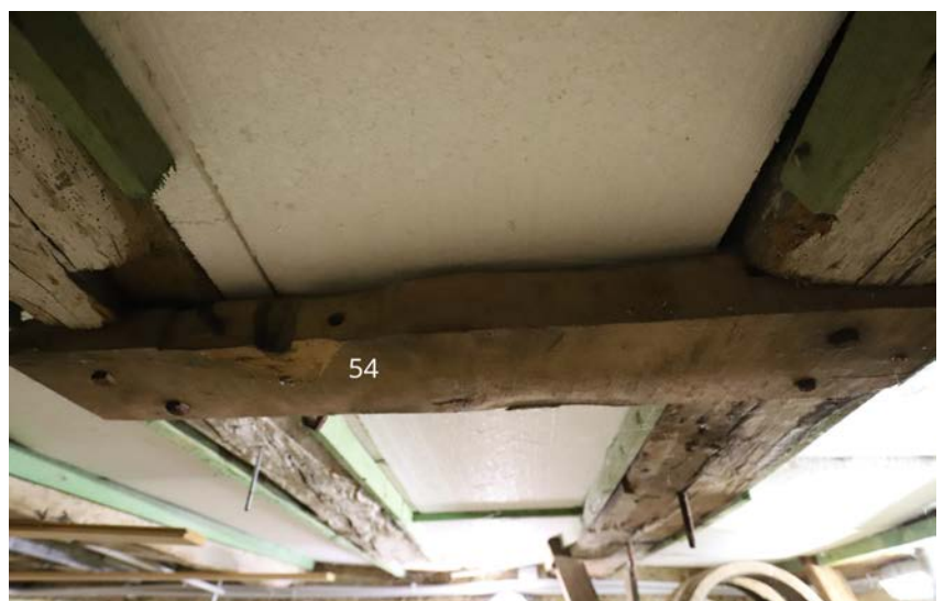
2.14 | Oberes Kellergeschoss: Balken an der Decke zur Zapfenfixierung des Steinkrans an Mahlgang 2.
