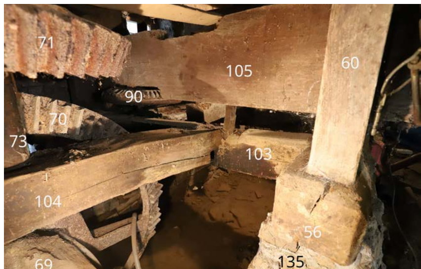
2.54 | Unteres Kellergeschoss, Mahlstuhl: Aufhelfbalken (105) des Lichtwerks von Mahlgang 2 und stehendes Vorgelege.
