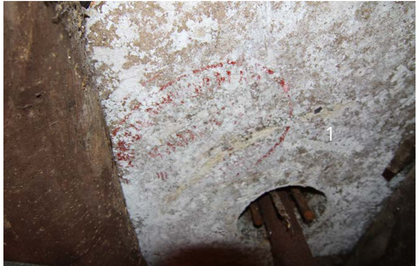
1.57 | Unteres Kellergeschoss: Lieger von Mahlgang 1 von unten.
