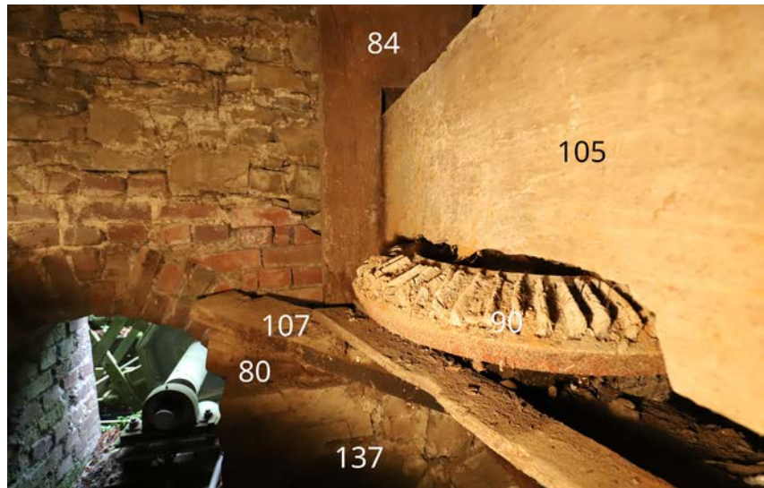
2.52 | Unteres Kellergeschoss, Mahlstuhl: Aufhelfbalken (105) des Lichtwerks von Mahlgang 2; Tellerrad (90) vom Antrieb der unteren Riementransmissionswelle.
