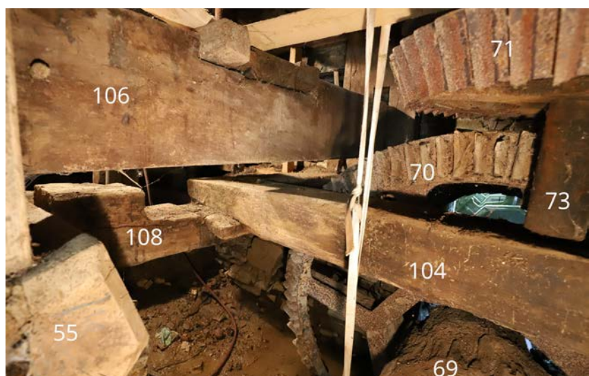
2.53 | Unteres Kellergeschoss, Mahlstuhl: Aufhelfbalken (106) des Lichtwerks von Mahlgang 1 und stehendes Vorgelege.
