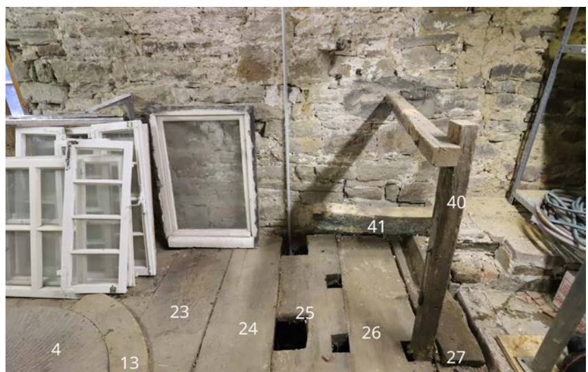
2.04 | Oberes Kellergeschoss: Bodenöffnungen unter der Transmission.
