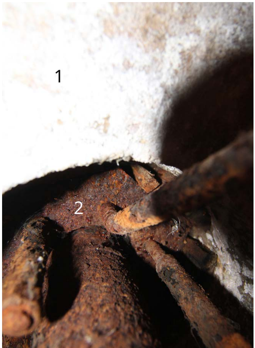
1.60 | Unteres Kellergeschoss: Lieger von Mahlgang 1 (Detail) von unten.
