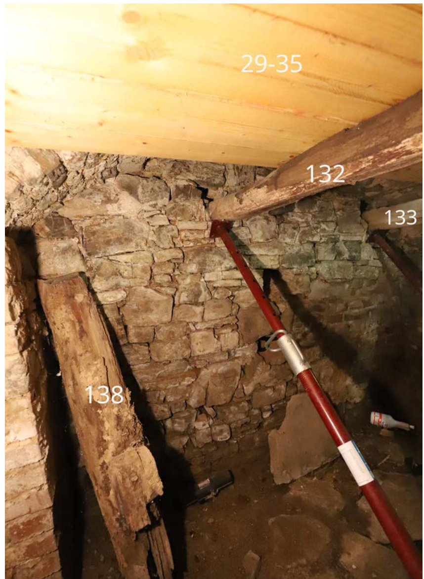
2.76 | Unteres Kellergeschoss, Arbeitsgang, Balken ohne Funktion (138)
