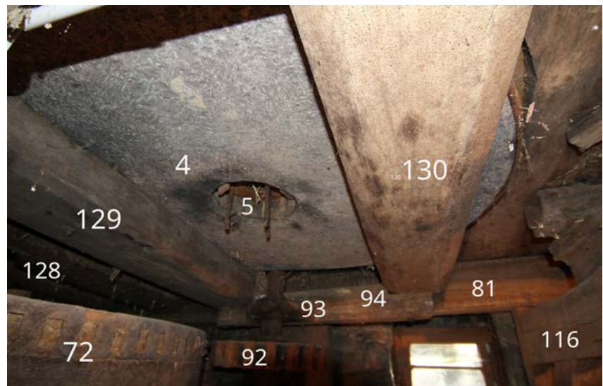
1.25 | Unteres Kellergeschoss: Lieger (Bodenstein) von Mahlgang 2 von unten.
