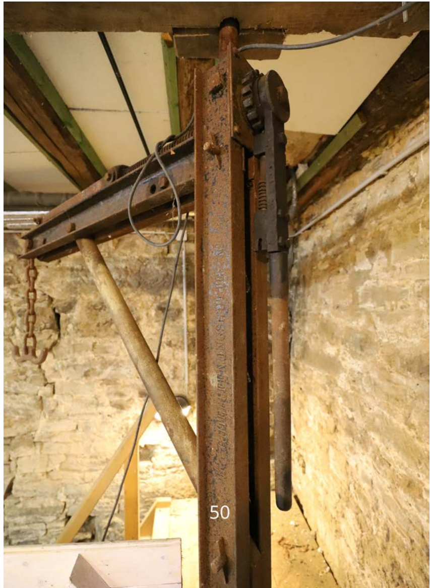
2.23 | Oberes Kellergeschoss: Steinkran (Detail).
