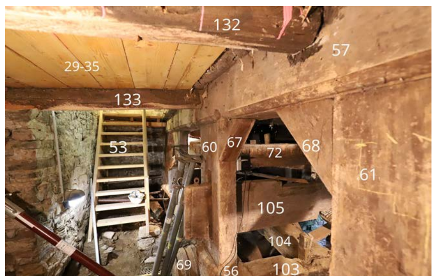
2.74 | Unteres Kellergeschoss, Mahlstuhl, Arbeitsgang und Zugangstreppe, Blick nach NO.
