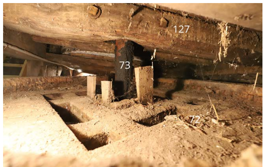
2.63 | Unteres Kellergeschoss, Mahlstuhl: Obere Lagerung der Königswelle (73).
