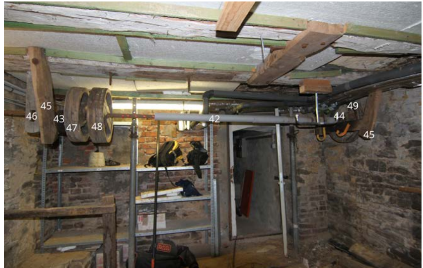
1.06 | Oberes Kellergeschoss: Riementransmission und Durchgang zum Heizungskeller.
