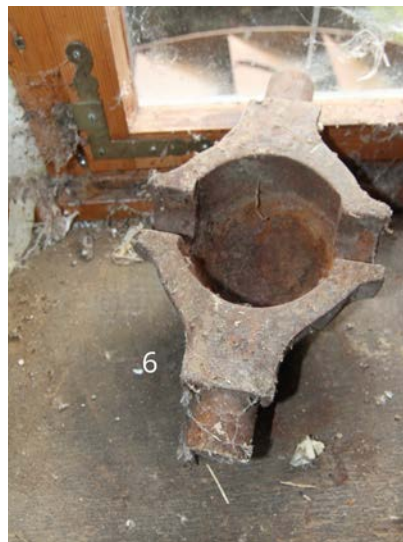
1.14 | Oberes Kellergeschoss: Kugelkopfhaue. Unterseite.
